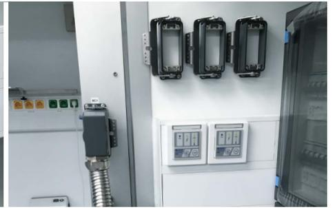
加是使用高度集成的模块化连接器的原因，因为这类连接器可以确保方舱的滑动部分可以轻松安全地连接到电源和医用气体。史陶比尔 CombiTac 连接器系统确保此类连接快速可靠，并满足所有要求。同时无需电气专家即可轻松安装。
